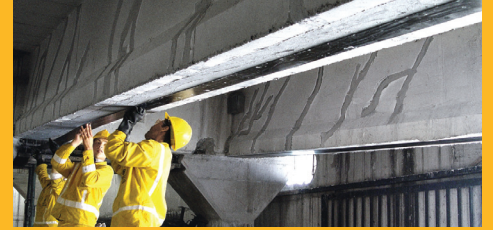
REPARACIONES Y REFUERZOS
