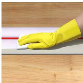
2. Antes de la aplicación del adhesivo Sikadur®- 31 Normal, colocar cinta de enmascarar sobre la junta o grieta y en ambos lados externos al área de aplicación.
