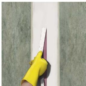
5. Aplicar la cinta Combiflex® SG-10 M mientras el adhesivo esté fresco, dentro del tiempo abierto del mismo. Presione la cinta de manera firme con rodillo para evitar dejar aire ocluido. El adhesivo debe brotar en ambos lados de la cinta 5 mm aprox.
