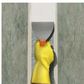
4. Quitar la cinta de enmascarar de la zona central de la junta de dilatación o grieta antes de la colocación de la cinta Combiflex® SG-10 M.
