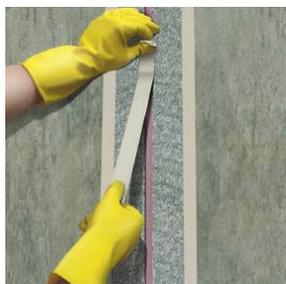
3. Aplicar Sikadur®- 31 Normal a ambos lados de la junta o grieta. El espesor de la capa de adhesivo debe ser de 1 a 2 mm y al menos de 4 cm de ancho a cada lado de la junta o grieta.
