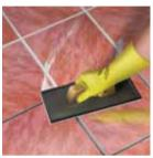
Mortero epoxi para juntas antiácidas entre cerámicas
