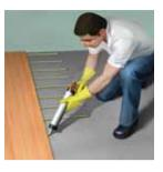
Adhesivo elástico poliuretánico tixotrópico para el pegado de pisos de madera por sistema de cordones y para Sika® AcouBond-System.
