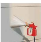
Compuesto liquido para el curado del hormigón
