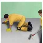
Morteros epoxi-cementiceo autonivelante para pisos de alto tránsito
