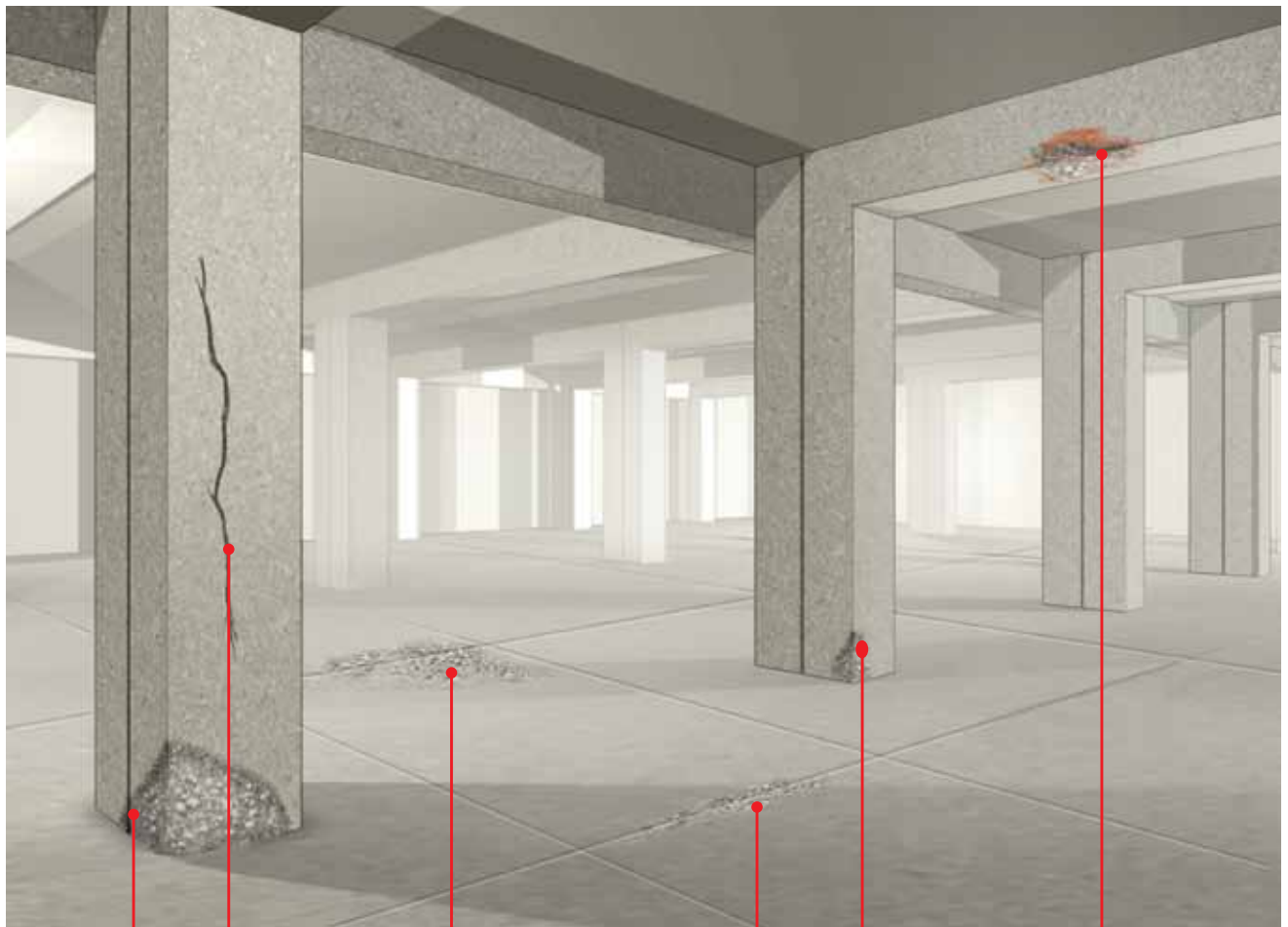
Figura N° 1: Diferentes tipos de daños en estructuras de hormigón
