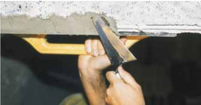
Reparación de recubrimiento con Sika® MonoTop®-615 / 312-NFG .
