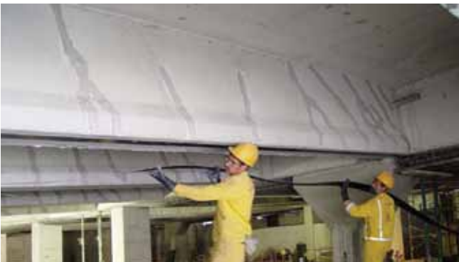
Inyección con Sikadur® 52 y refuerzo mediante Sika® Carbodur® .
