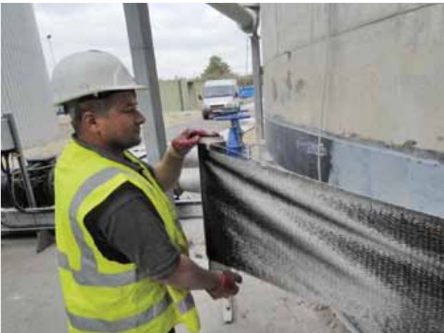
Refuerzo con SikaWrap® de fibra de carbono.
