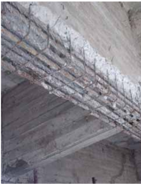
Limpieza y retiro de hormigón débil.
