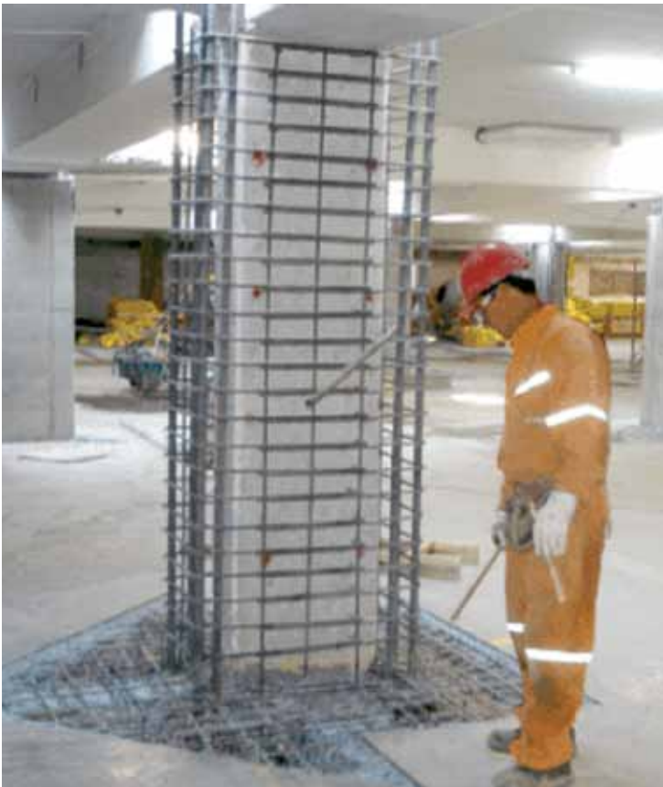
Encamisado de columna con SikaGrout®-212 utilizando Sikadur® 32 Gel como puente de adherencia.
