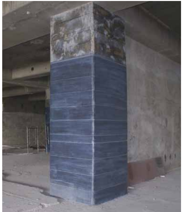
Confinamiento de columna con tejido de fibra de carbono SikaWrap® .
