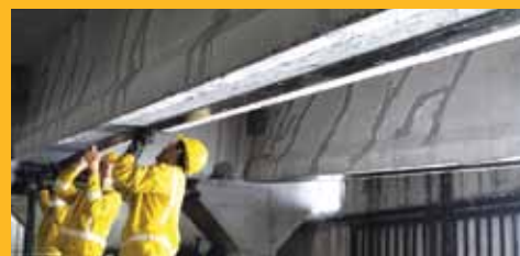
REPARACIONES Y REFUERZO
