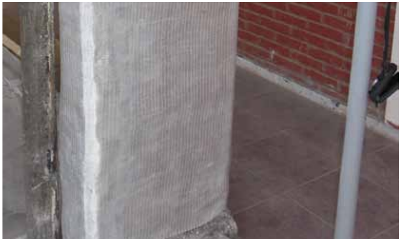
Refuerzo con SikaWrap® 100 G de fibra de vidrio.
