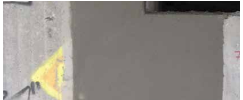
Reparación de la sección de hormigón con Sika® MonoTop®-615 / 312-NFG .
