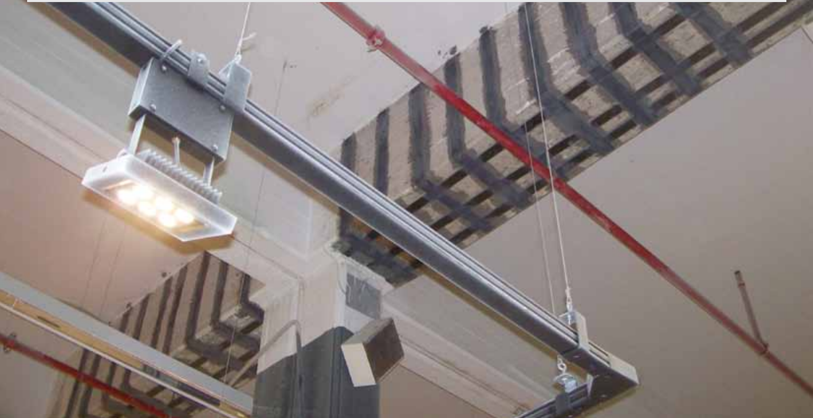
Refuerzo estructural con tejido de fibra de carbono SikaWrap® 103 C y láminas de fibra de carbono Sika® Carbodur® S512 .
