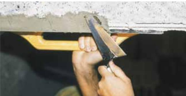
Reparación de recubrimiento con **Sika® MonoTop®-615 / 312-NFG**.
