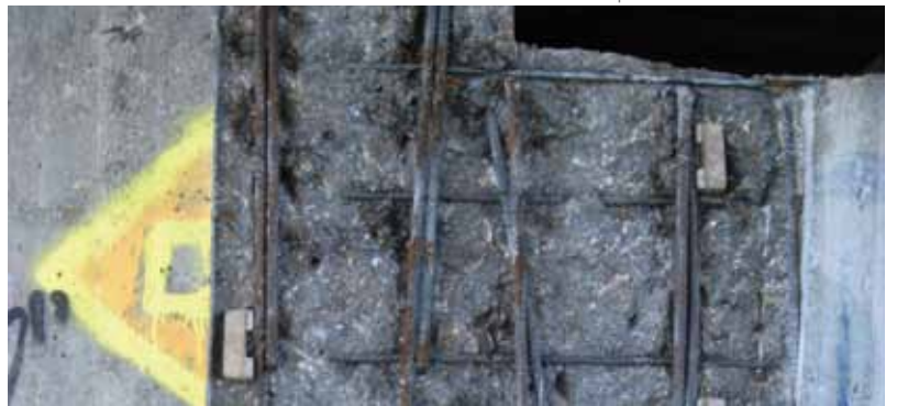
Limpieza y pasivación de armaduras con SikaTop® Armatec® 110 EpoCem® .
