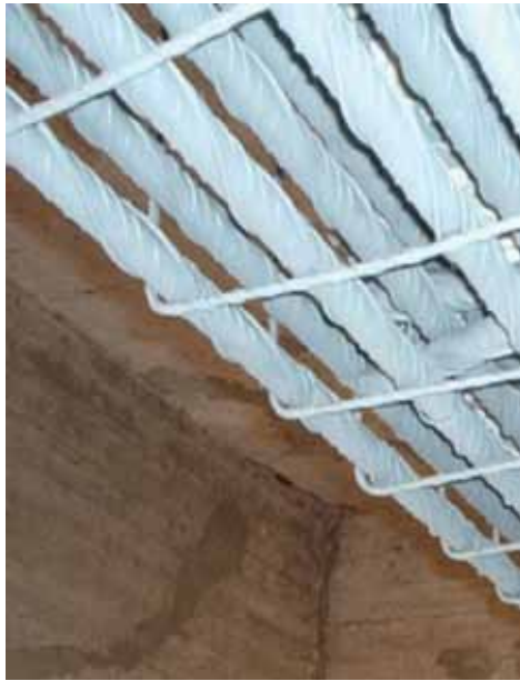
Retiro del óxido de las armaduras.
