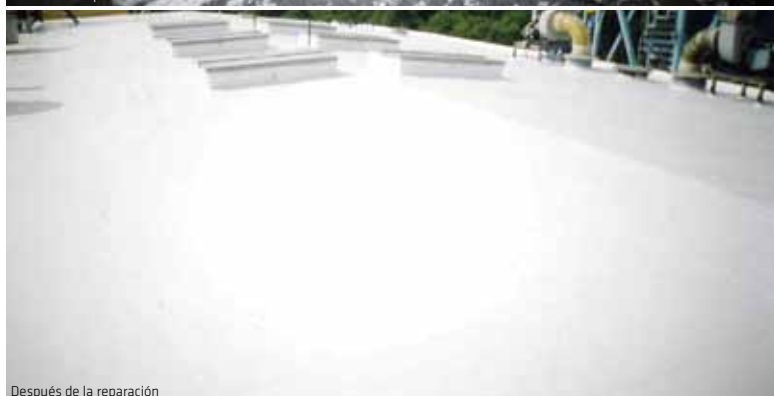
Después de la reparación
