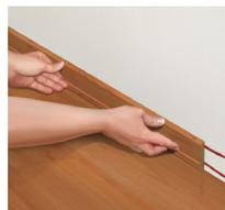
8. El espesor final de la capa del adhesivo una vez unidas las partes debe ser entre 1 - 3 mm. El tiempo de agarre inicial será más rápido, en espesores de 1 mm. La resistencia final de la unión se alcanza después que **SikaBond® Montaje** ha curado por completo.
