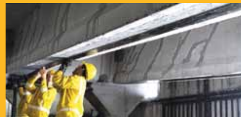
REPARACIONES Y REFUERZO
