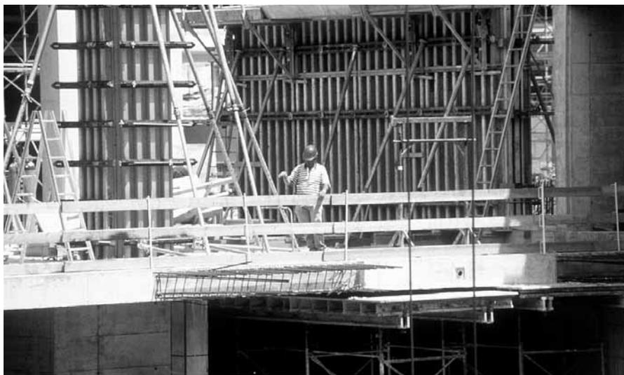
Muchos factores tienen influencia sobre la calidad del acabado del hormigón, incluyendo la composición del hormigón, las materias primas, el encofrado que se use, la capacidad de compactación, la temperatura, el curado y el agente desencoformante que se elija. Más abajo describimos el efecto del agente desencoformante y aconsejamos sobre su selección y uso correcto.
