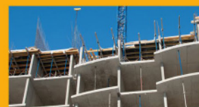
FUNDICIÓN IN-SITU Y PREFABRICADOS DE CONCRETO
