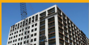
REPARACIÓN DE CONCRETO
