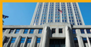
REPARACIÓN Y PROTECCIÓN
