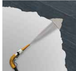
Fig. 8-2: Rellenar de vacíos
