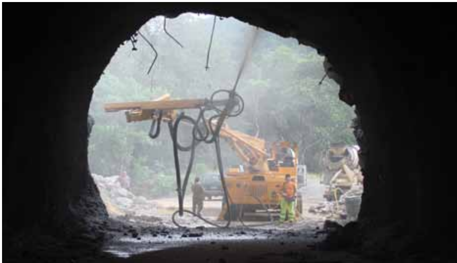
Fig. 2-1: Proyectado de hormigón con Sika®-PM 500
