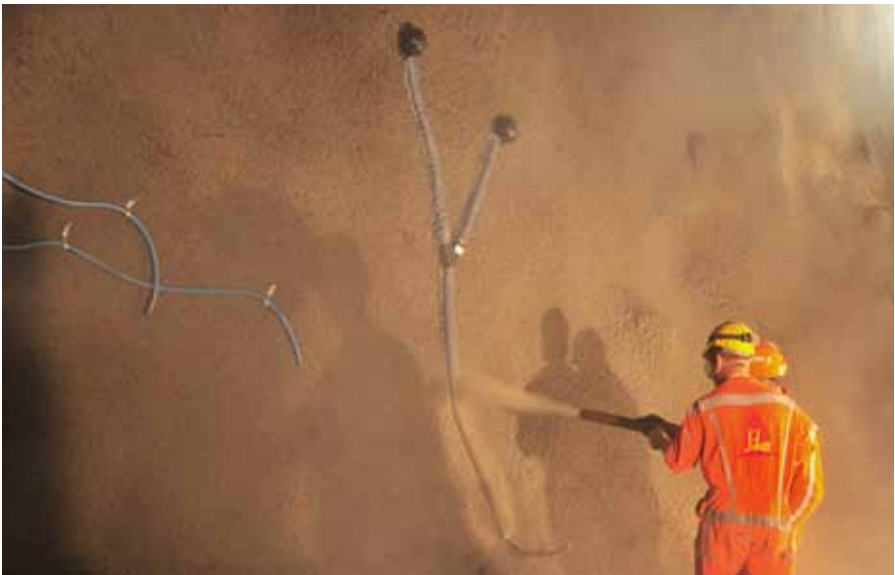
Fig. 11-3: Fijación del FlexoDrain W con Sika® Shot-3
