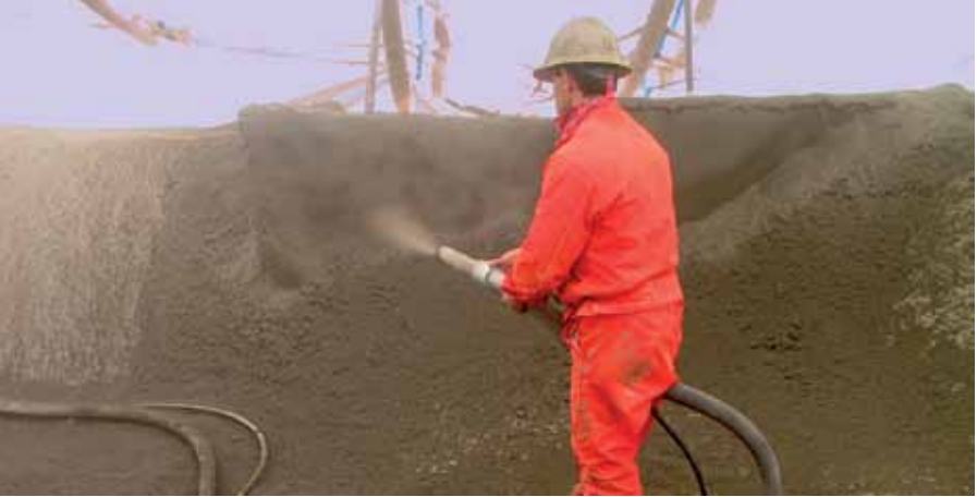
Fig. 2-2: Proyectado en seco [Dry spraying]
