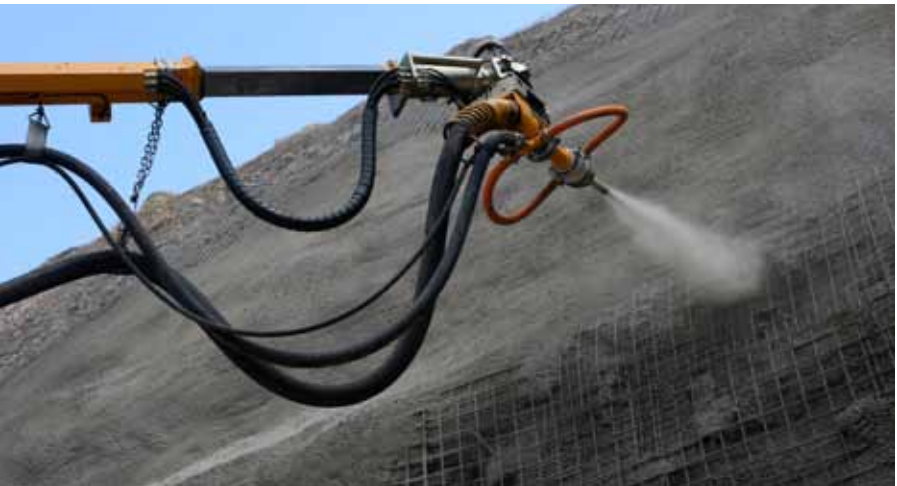
Fig. 2-3: Proyectado húmedo [Wet spraying]
