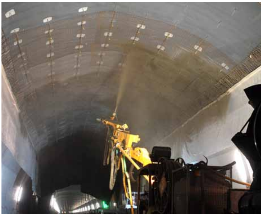
Fig. 3-10: Revestimiento con hormigón proyectado
