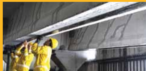
REPARACIONES Y REFUERZO
