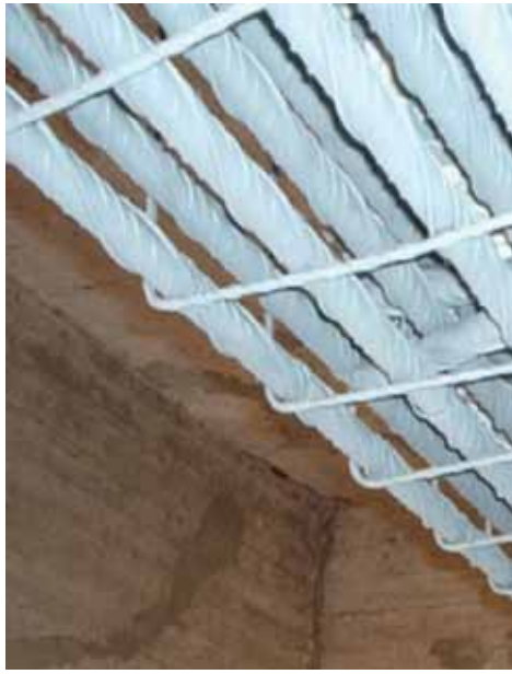
Retiro del óxido de las armaduras.
