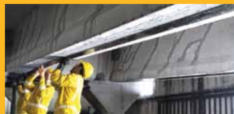
REPARACIONES Y REFUERZO
