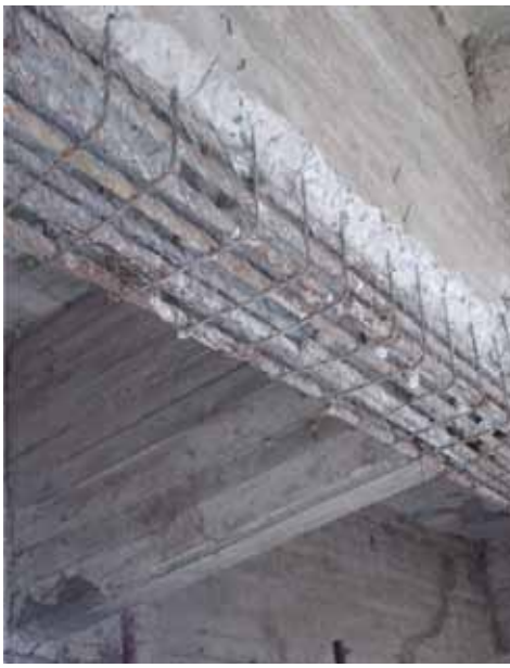
Limpieza y retiro de hormigón débil.
