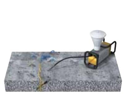
**4.** Cuando el material de inyección salga por el segundo packer, fijar en este la válvula anti-retorno lo más rápido posible. Dejar de inyectar en el primer packer y comenzar a hacerlo en el segundo. Repetir este proceso en todos los packers.
