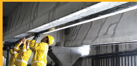
REPARACIONES Y REFUERZOS
