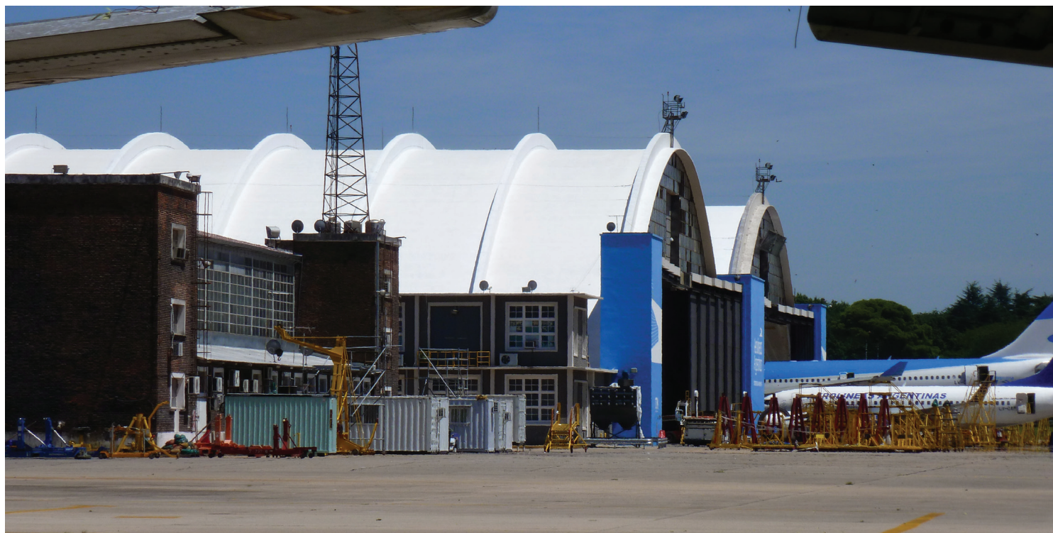
IMPERMEABILIZACIÓN DE TECHOS EN HANGARES 3 Y 4, EZEIZA. AEROLÍNEAS ARGENTINAS, CON MEMBRANA LÍQUIDA CON POLIURETANO SIKALASTIC®-560
