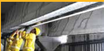
REPARACIONES Y REFUERZO
