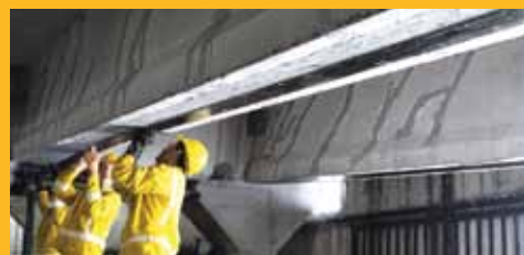
REPARACIONES Y REFUERZO
