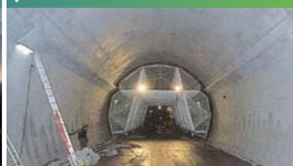
Agiliza el proceso de construcción ya que permite liberar el encofrado antes
