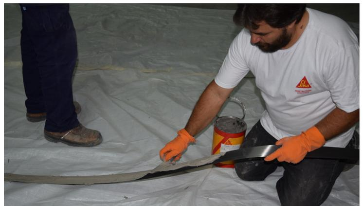
Para realizar esta intervención, primero se trabajó sobre el hormigón hasta dejar al descubierto las armaduras existentes y comprometidas. Se realizó la limpieza y posterior pasivado de las mismas con **SikaTop® Armatec®-110 EpoCem**, producto a base de cemento y resinas epoxi modificadas, de tres componentes, que actúa como inhibidor de la corrosión, puente de adherencia y protección anticorrosiva de las armaduras.
