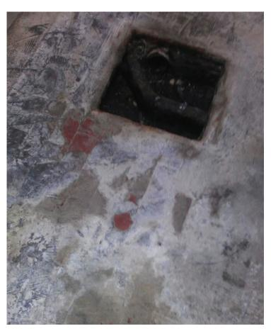
base del sustrato y llegar a sustrato firme, luego se aplicó la malla Armatex 44 junto con el Sikafloor® 161 para brindarle una mejor nivelación y mayor capacidad de absorber movimientos del piso original.
