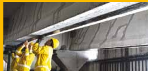
REPARACIONES Y REFUERZO
