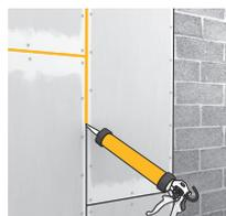
5. En general, Sikaflex®-105 Metales adhiere sin promotores de adherencia. En aplicaciones críticas se recomienda realizar un ensayo de adherencia previo al sellado.
