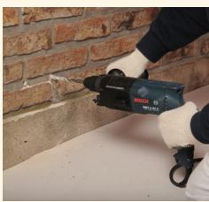
Perforar en una sola línea en el mortero de asiento entre ladrillos (macizos, huecos, piedras, bloques) a no más de 15 cm del nivel de piso terminado. Usar mecha de 12 mm en posición horizontal. La distancia entre los orificios debe ser de 12 cm entre sí. La profundidad de los orificios será del 90% del espesor del muro.
