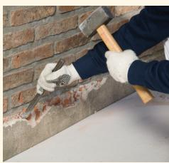
Quitar los zócalos y si el revoque está contaminado con sales o se ha dañado, debe ser removido. Dejar expuesta la mampostería a tratar. Medir el espesor de la pared.
