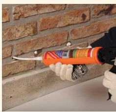
Extraer el polvillo de cada orificio con aspiradora o soplete. Insertar la manguera cristal en toda la profundidad del orificio. Rellenar cada perforación una única vez con **SikaMur® Injecto-Cream-100** desde lo más profundo hacia afuera hasta llegar a 1 cm de la superficie. El efecto bloqueo de la humedad ascendente, comienza a medida que se produce la impregnación del mortero. No obstante se recomienda esperar que el muro seque, antes de proceder a revocarlo.
