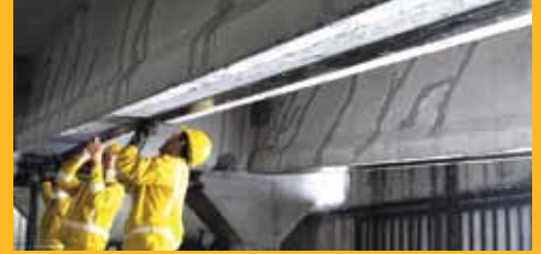
REPARACIONES Y REFUERZO
