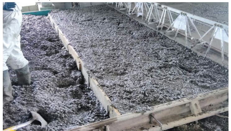
4. Proceso de regleado y vibración.
