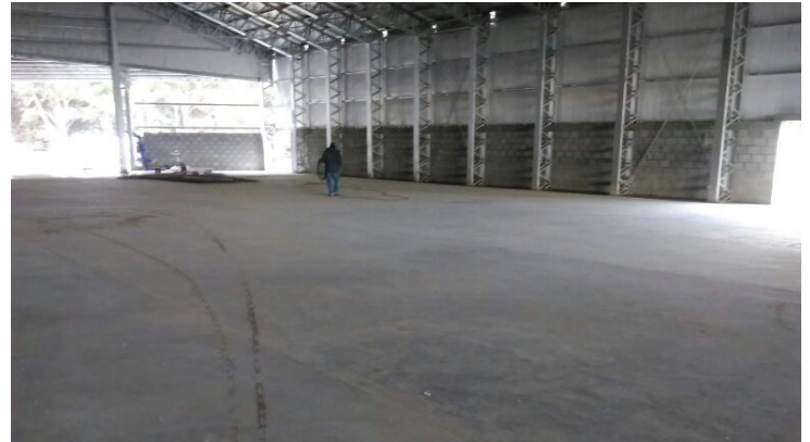
7. Hormigón alisado terminado.
