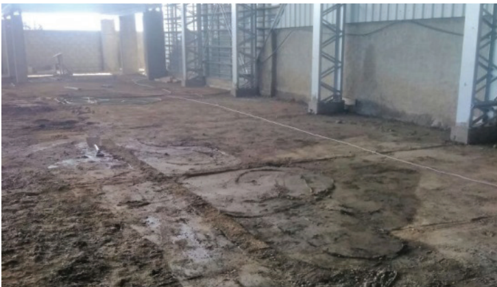
1. Compactación de la base.
