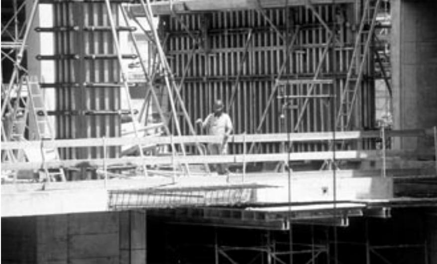
Muchos factores tienen influencia sobre la calidad del acabado del hormigón, incluyendo la composición del hormigón, las materias primas, el encofrado que se use, la capacidad de compactación, la temperatura, el curado y el agente desencofrante que se elija. Más abajo describimos el efecto del agente desencofrante y aconsejamos sobre su selección y uso correcto.
