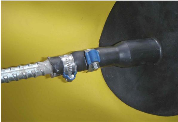
Instalar según lo validado en el Método Declarado y detalle estándar del dibujo para la impermeabilización de subsuelos y túneles con membranas Sikaplan® WP. Colocar Sikaplan® WP Trumpet Flange por encima de la membrana.
