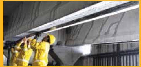
REPARACIONES Y REFUERZO
