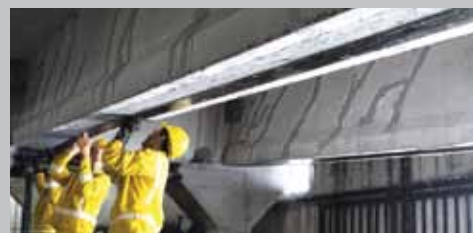
REPARACIONES Y REFUERZO
